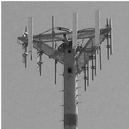
Рис.1. Антенны трех базовых станций на мачте
