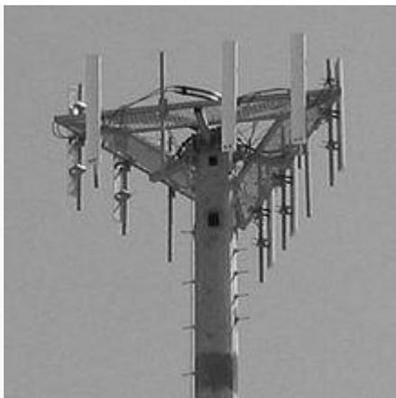
Рис.1. Антенны трех базовых станций на мачте
