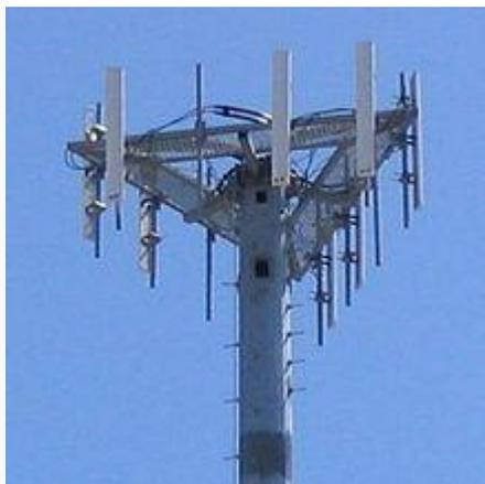
Рис.5.1. Антенны трех базовых станций на мачте
