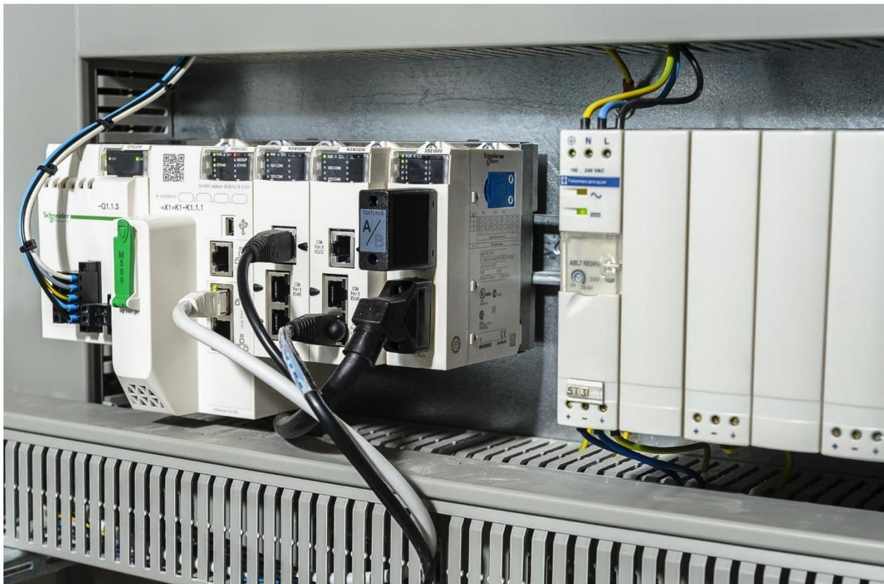
Рисунок 2.11 – Распределенная конфигурация контроллера
