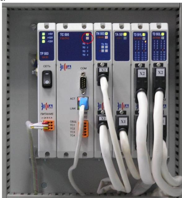
Рисунок 8.3 – Индикация работы промышленного контроллера
