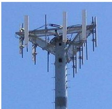
Рис. 5.1. Антенны трех базовых станций на мачте
